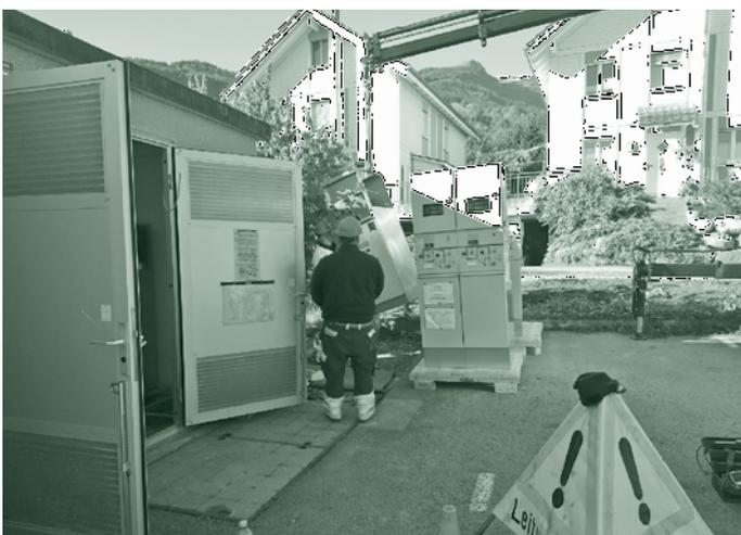
Im Weiteren wurden die in den Vorjahren begonnenen Umbauten an Transformatoren weitergeführt. Durch den berührungssicheren Umbau wird die Stromabgabe bei Reinigungsarbeiten nicht mehr unterbrochen. Zudem wird eine Erhöhung der Arbeitssicherheit erzielt.
