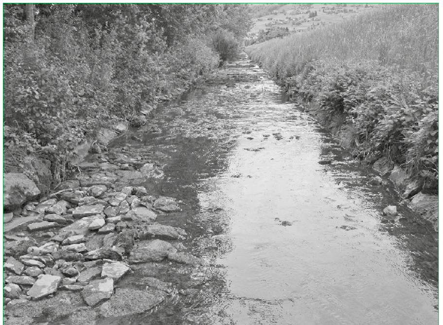
Das stark kanalisierte Gerinne bietet bei Niederwasserführung keine Durchgängigkeit oder Rückzugsmöglichkeiten für die Fische.
