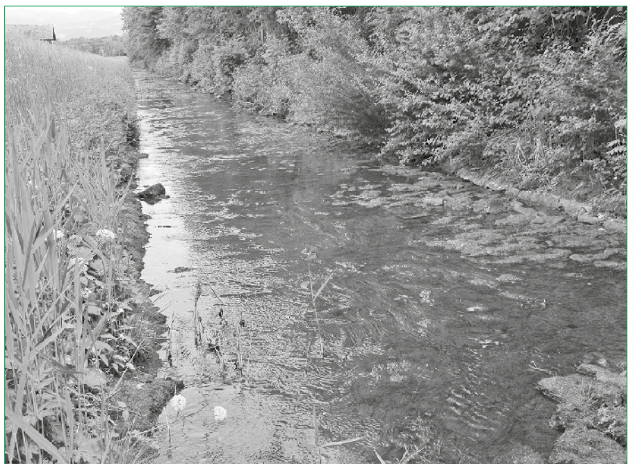
Das stark kanalisierte Gerinne bietet bei Niederwasserführung keine Durchgängigkeit oder Rückzugsmöglichkeiten für die Fische.
