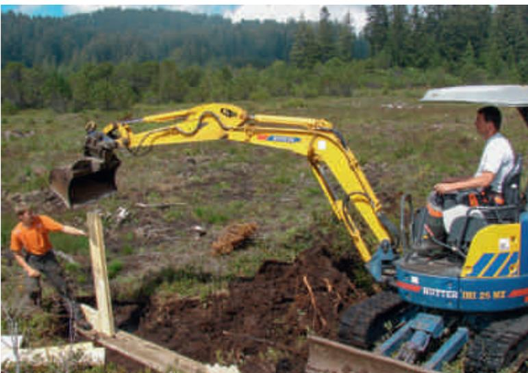
In einem Abschnitt blieb der Hauptgraben offen, dort entstand ein grosser Weiher (STAUB et al. 2011). Nach der Schliessung des Hauptgrabens verschloss man auch die kleineren, querliegenden Seitengräben mit Holzspundwänden und Torf (Abb. 12).
