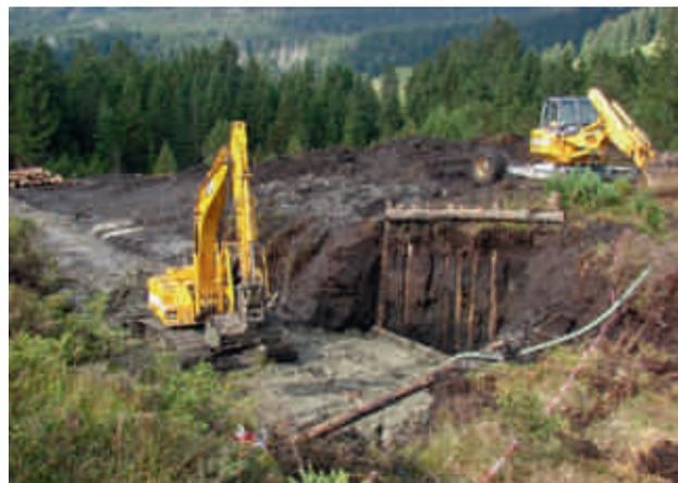
*Abb. 9 Auffüllen des Hauptgrabens im steilen Abschnitt mit Lehm 2010. Dieser Lehmdamm stabilisiert auch die querliegenden Holzkästen. (Foto: Andreas Grünig)*
