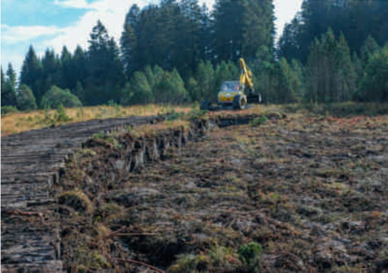
**Abb. 11 Abschluss des Grabens im Osten durch einen Lehmriegel und vorgelagerten Torf. (Foto: Rudolf Staub)**
