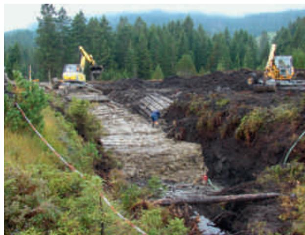
**Abb. 10 Gewinnung des Torfs durch Abtiefung des Geländes und Versetzen der Vegetationsschicht. (Foto: Rudolf Staub)**
