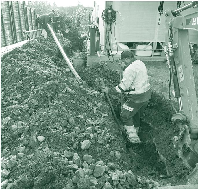
In diversen Gebieten oder Strassenzügen sind die Leitungen erweitert oder erneuert worden. Dies im Zuge von Werkleitungssanierungen, -erweiterungen oder -neuerschliessungen. Die Investitionen dienen sowohl heutigen und künftigen Bautätigkeiten als auch der Versorgungs- und Arbeitssicherheit.
