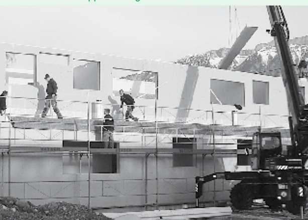
Doppelkindergarten Unterdorf im Bau.
