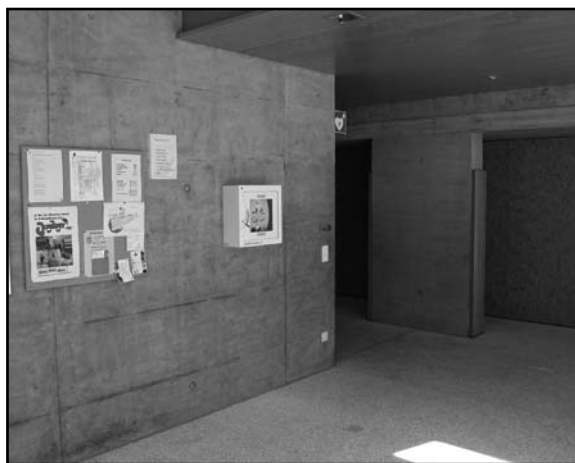
Der Standort des Defibrillators im Foyer der Mehrzweckhalle Unterdorf.
