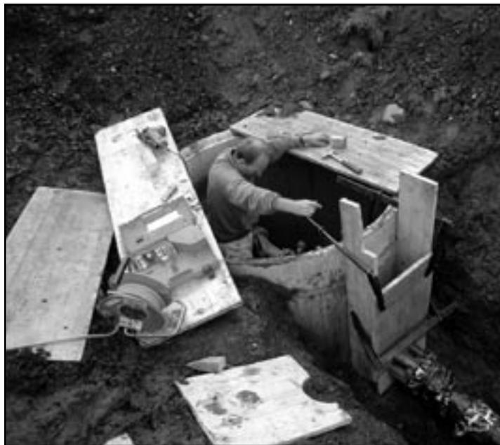
Betonierungsarbeiten am Druckbrecherschacht Vogelegg.
