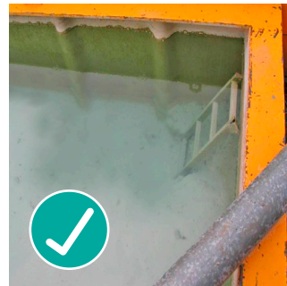
Becken mit guter Absetzwirkung
