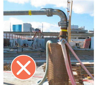
Keine Einleitung von Baugrubenabwasser ins Grundwasser!
