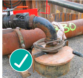
Abgedeckter Filterbrunnen
