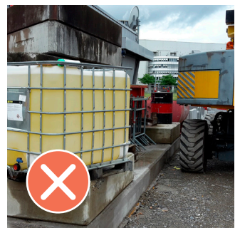
Auffangwanne fehlt, Abstand von Baumaschine zu gering
