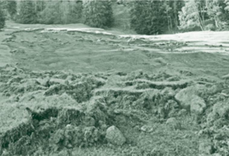
Im Frühling 2012 wird maschinell grob planiert und unterhalb des Abrissansatzes werden Stecklinge gesetzt
