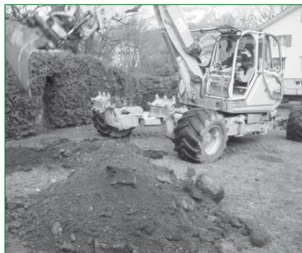
Vielleicht ist der Bevölkerung aufgefallen, dass in der letzten Zeit bereits einige Arbeiten stattgefunden haben. Für die Feststellung der Bodenbeschaffenheit und als Grundlage für den Statiker wurden im Beisein eines Geologen Bagger-schlitzte mit einer Tiefe von ca. vier Metern ausgehoben. Diese geben Hinweise, in welcher Art die Foundation geplant werden muss.
